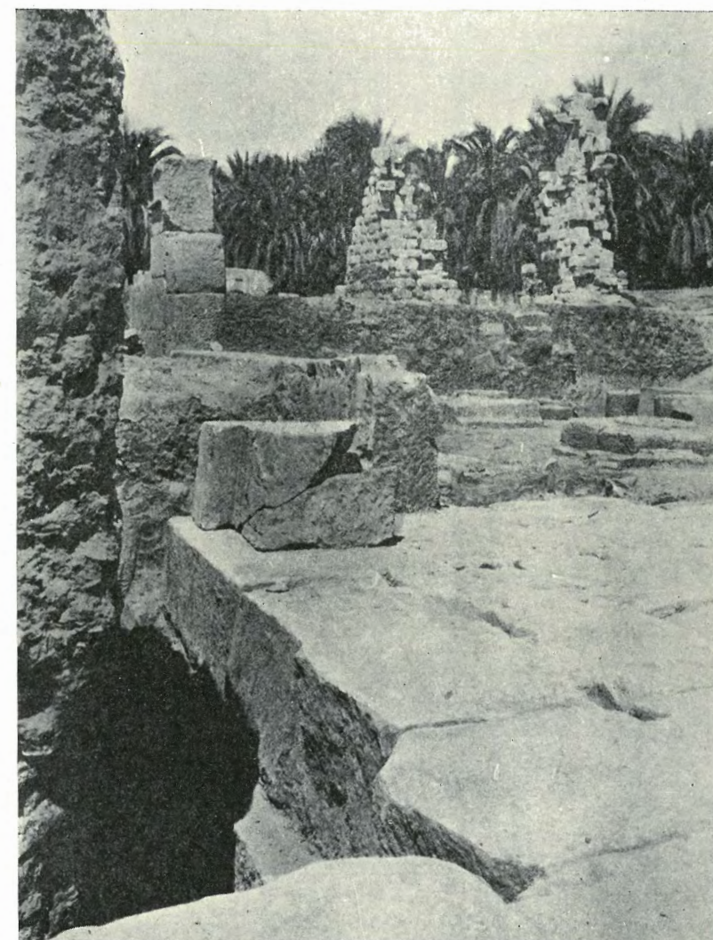
Fig. 13. — LA PIERRE D'ANGLE SUD-OUEST DU MUR-PYLÔNE EN PLACE.
